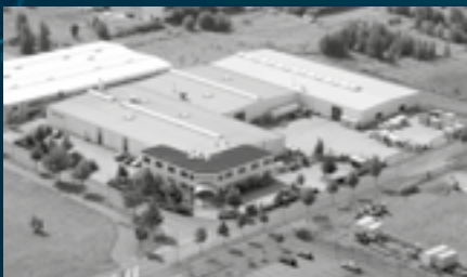
BOSECKER VERTEILERBAU SACHSEN GMBH, ZITTAU
