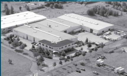
BOSECKER VERTEILERBAU SACHSEN GMBH, ZITTAU
